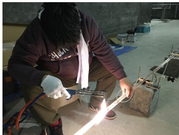
図 6 ひずみ計組み立て時の写真 (ガラス管の接続)
