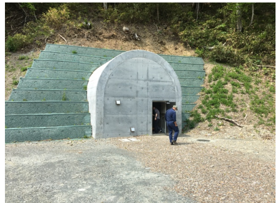
図2 新天塩中川観測所、坑道入口写真
