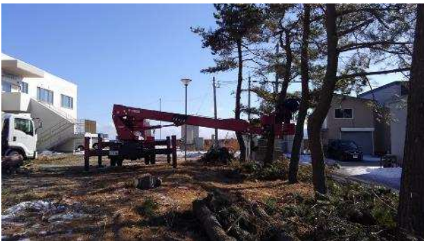
図 1: 高所作業車での剪定作業(臼尻水産実験所)
